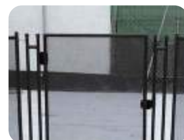
Πόρτα με αυτόματο κλείσιμο. Άνοιγμα πάντα προς τα έξω & να κλειδώνει πάντα προς την πισίνα. Automatic self closing gate. Opening always towards the outside & lock towards the pool.
